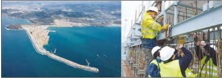
**Fig. 4: Puerto exterior de Langosteira (La Coruña): colocación de sensores de corrosión en uno de los cajones**
