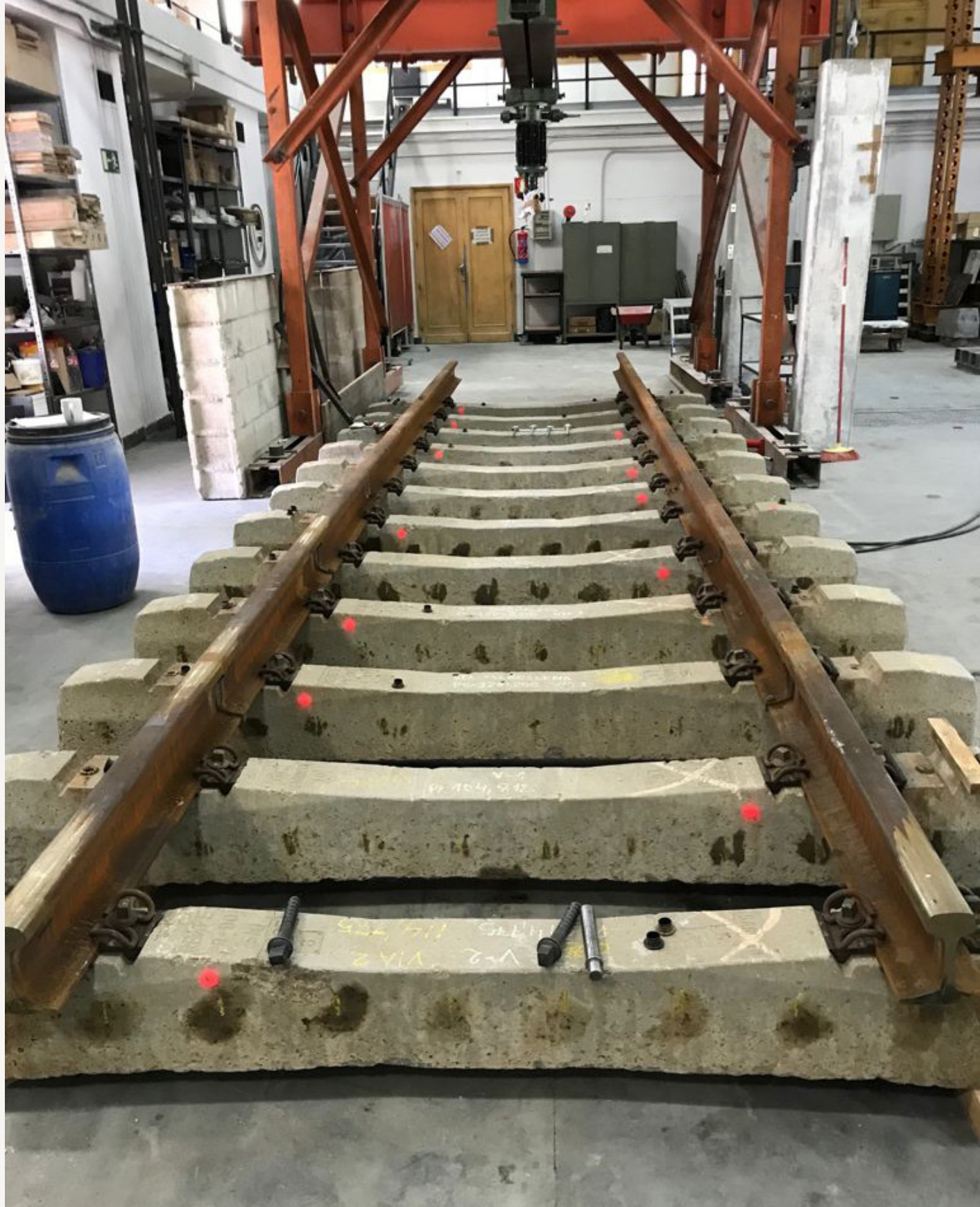
Montaje de tramo de vía de alta velocidad
