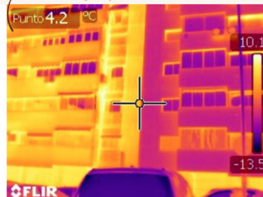
Imágenes termográficas. Antes y después de rehabilitar
