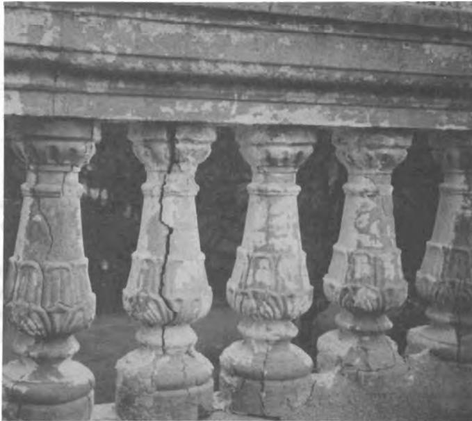
Figura I.28.—Balastrada prefabricada que se ha agrietado por corrosión de la armadura central.
