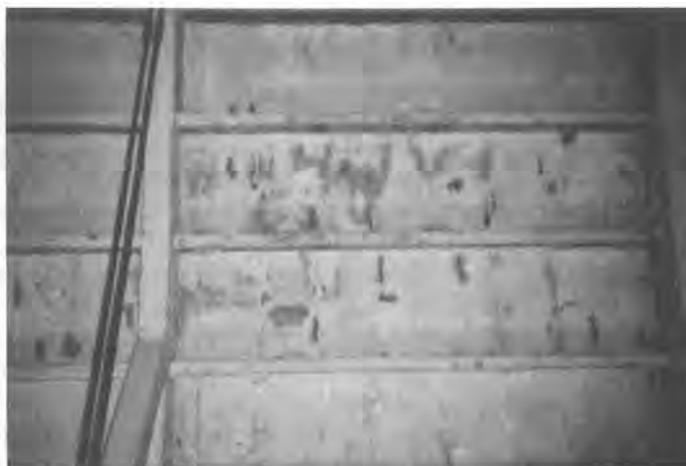
Figura 1.29.—Elementos prefabricados de cerramiento superior corroídos debido al poco espesor de recubrimiento.
