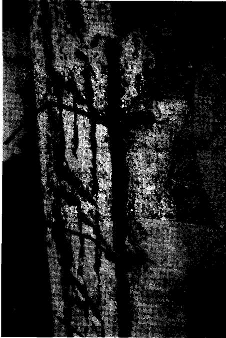
Figura I.8.—Caso real de corrosión por cloruros (picaduras y disminución de sección) en un pilar.
