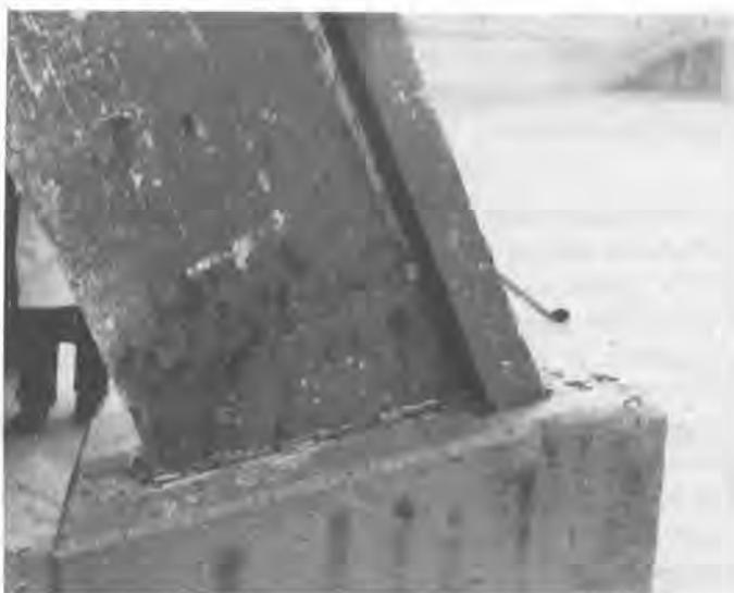
Figura I.22.—Manchas de óxido sobre la superficie de hormigón que no corresponden a la existencia de armaduras en su interior en las zonas donde aparece el óxido.
