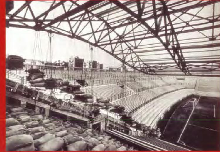
«De este modo se redujeron su canto y su coste, y el incremento de momento flector transmitido a las vigas inclinadas que sujetan las gradas no suponía un gran inconveniente, dada la gran rigidez del pórtico del que forman parte.
