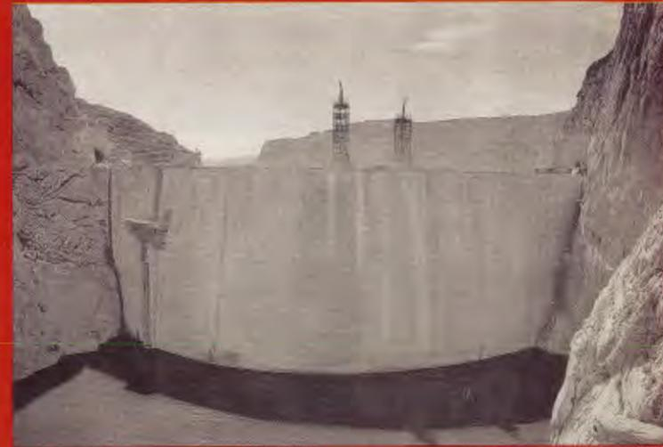
«Esta presa, de 140 m de altura, fue estudiada experimentalmente en 20 modelos reducidos sucesivos. Los resultados obtenidos de cada ensayo servían para determinar las variaciones de forma que convenía introducir; y esta forma era nuevamente experimentada.
