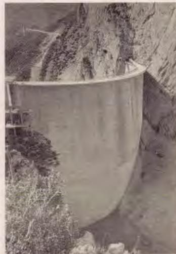
«La idea fundamental de este acueducto es la de suprimir la posibilidad de fisuración y de fugas, haciendo que el paramento en contacto con el agua esté sometido a compresión en todos los sentidos.
