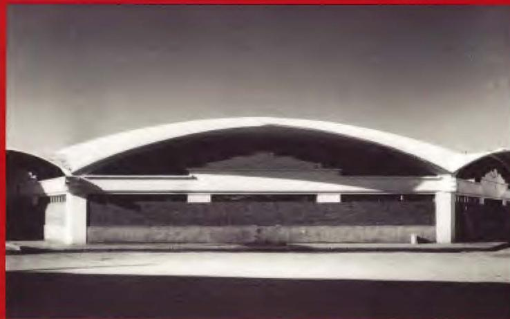
«El espesor de cálculo de la lámina es de 9 cm, pero aumenta gradualmente hasta los 50 cm en las proximidades de los soportes, para resistir la concentración de esfuerzos que aquí concurren. En cada uno de estos puntos, la componente vertical de la reacción es resistida por el propio soporte, mientras que la componente radial horizontal es contrarrestada por un anillo octogonal.»
