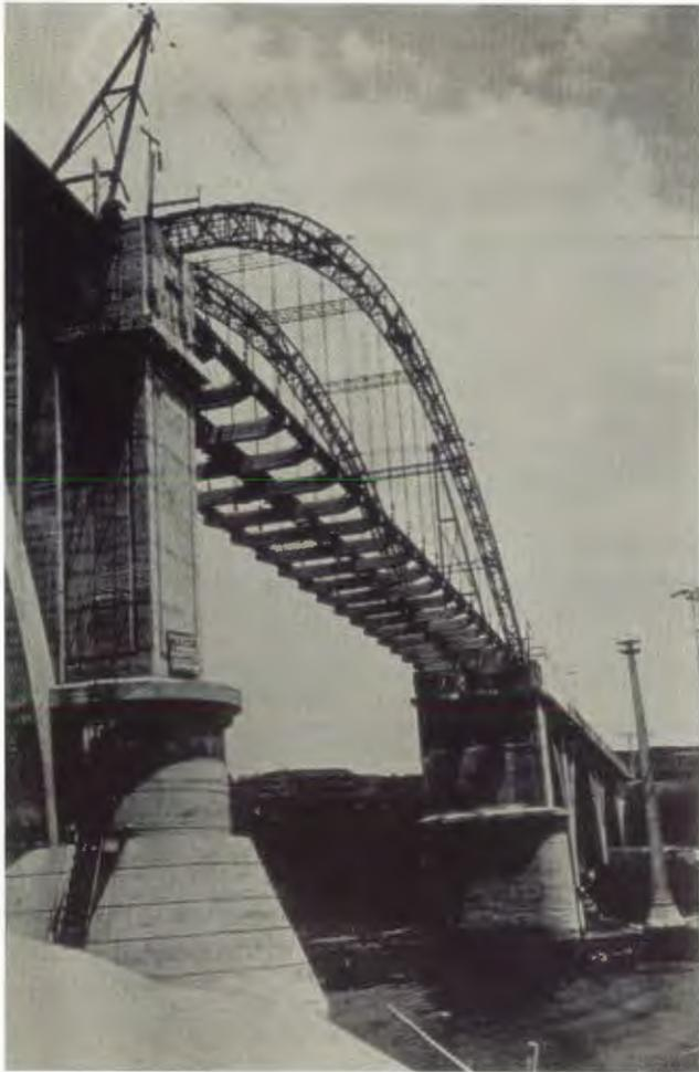
ques y 1,70 m en clave— y una anchura constante de 1,20 m, y arriostrado transversalmente mediante elementos de  $60 \times 60 \text{ cm}^2$  colocados cada 10,95 m coincidiendo con los ejes de las péndolas que sustentan el tablero —un forjado continuo de 3,65 m de luz apoyado sobre viguetas transversales de 7 m.
