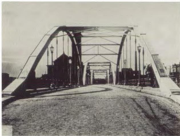
La viga de rigidez, de alma llena, está formada por una doble T de 1,66 m de canto —1/35 de la luz según la regla práctica al uso—, cabezas de  $450 \times 30$  mm, y alma de 15 mm de espesor, compuesta con tres palastros soldados.
