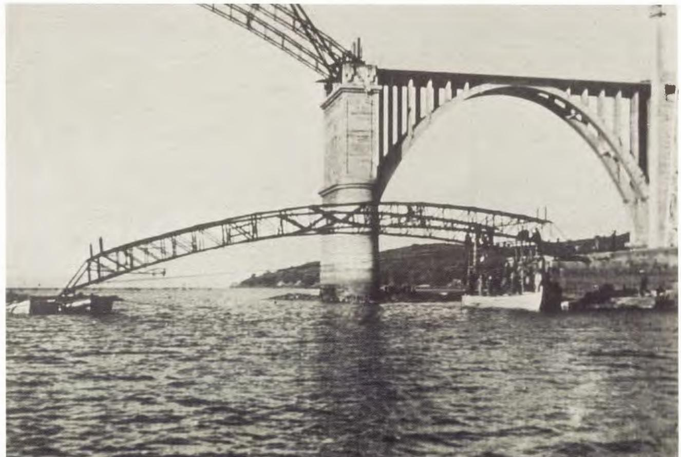
durante la construcción. Las viguetas transversales fueron fabricadas en taller y se suspendieron de las péndolas una vez hormigonado el arco.
