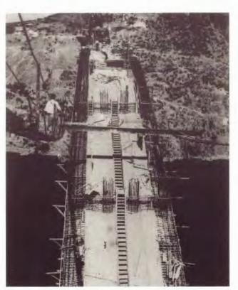
El tablero tiene una anchura constante de 8,80 m, y se soporta a base de empalizadas que apoyan sobre las bóvedas y sobre el arco, y sobre unos contrafuertes situados sobre los arranques del arco principal y al final de los viaductos de acceso.
