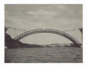
Concluido el hormigonado del arco, se procedió a la apertura de 9 cm en la clave, mediante la aplicación de treinta y seis gatos hidráulicos, para contrarrestar el acortamiento debido a retracción y deformación elástica.
