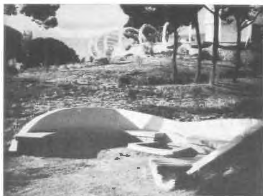
Alzado a poniente.—Chimenea térmica.—Fuente del pitorro.
