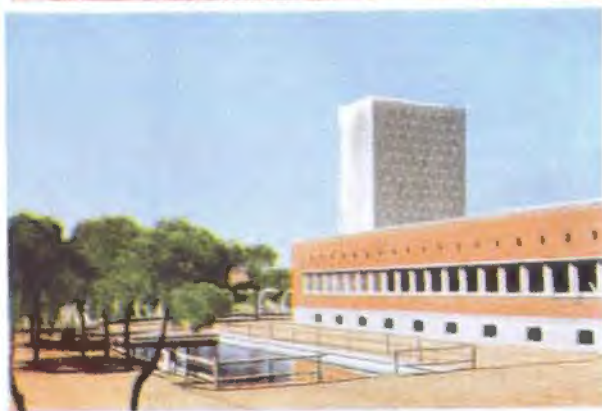
Central térmica en construcción.
