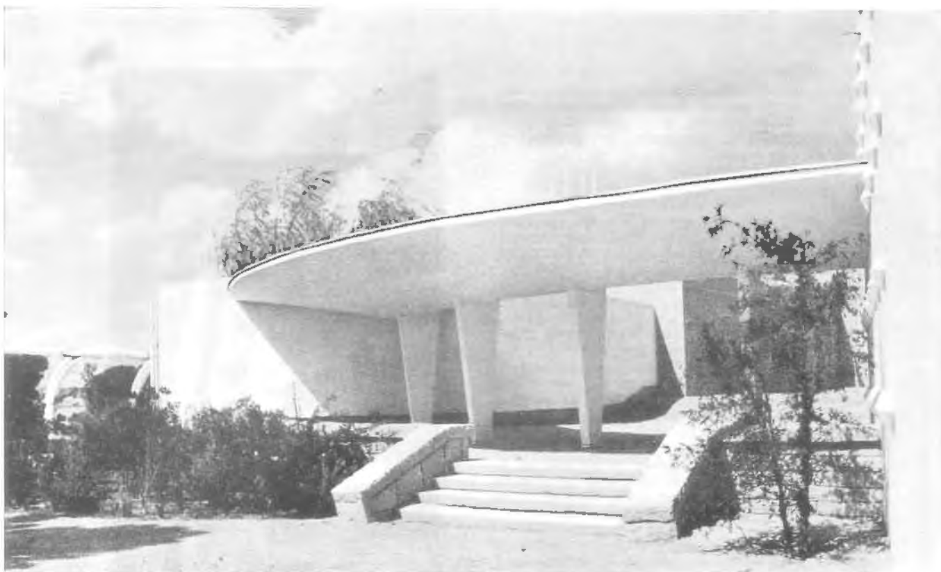
Pantalla de enlace Torre - Dirección. — Farol en acceso principal.
