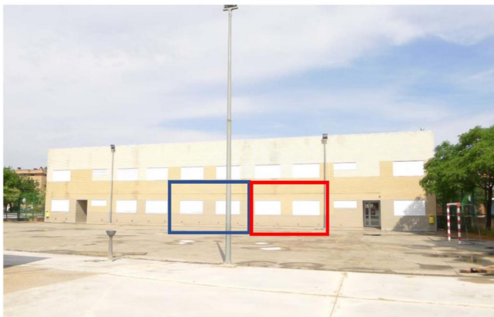
Figura 3: Fachada del edificio. En rojo aula A y en azul el aula B.
