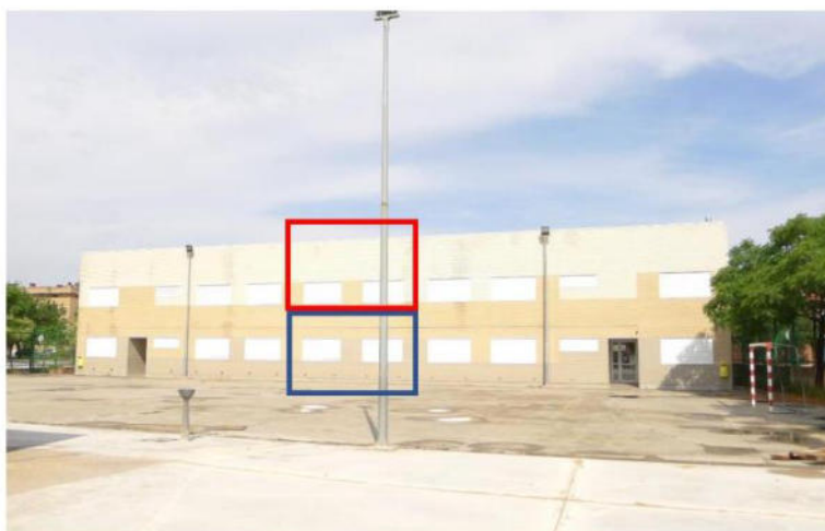
Figura 3: Fachada del edificio. En rojo aula A (recinto emisor) y en azul el aula B (recinto receptor).
